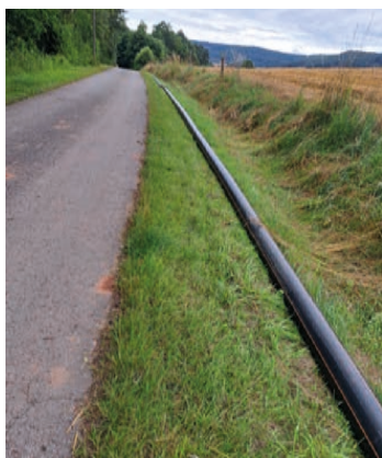
Leitungsbau im Bohrspülverfahren
