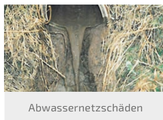
Hausanschluss – Außenkorrosion; Verbindungsstück Gewinderohr
