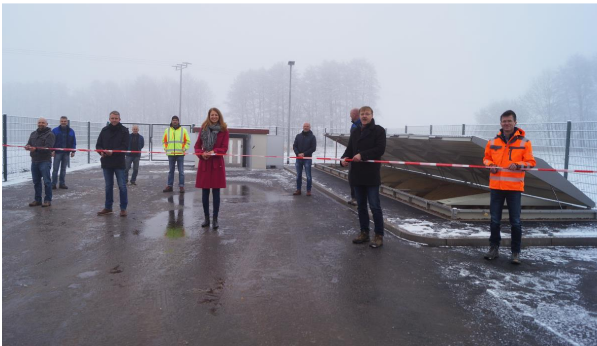
Die Kläranlage Ketten wurde mit dem symbolischen Bandschnitt offiziell in Betrieb genommen.
