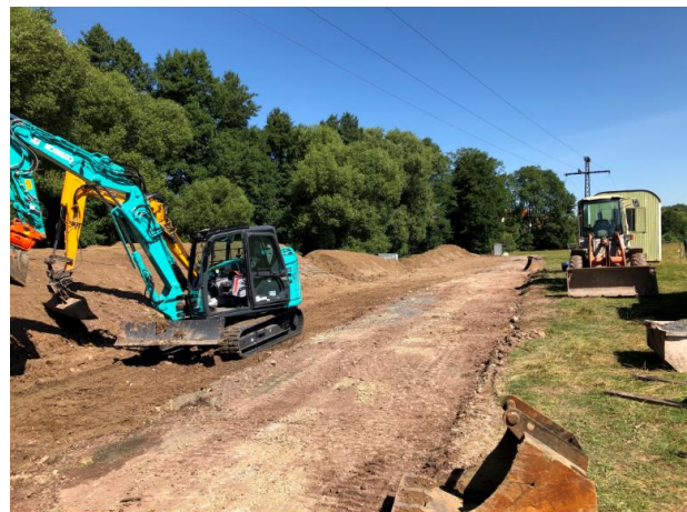
Bauarbeiten am Verbindungssammler zwischen Spahl und Geismar
