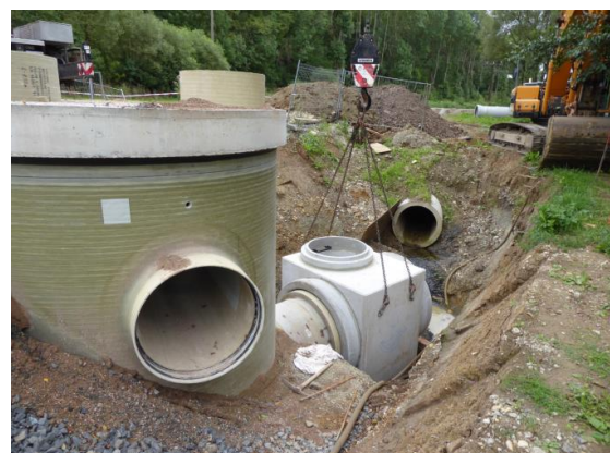
Setzen der Schächte für den Anschluss des Zulaufsammlers an den Stauraumkanal
