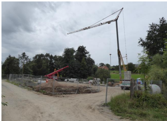
Baufeld für die Klieranlage, die Abwasserpumpstation und den Stauraumkanal
