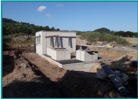
Das Abwasserpumpwerk in Fischbach fördert 70 Kubikmeter Abwasser pro Stunde zur Kläranlage.
