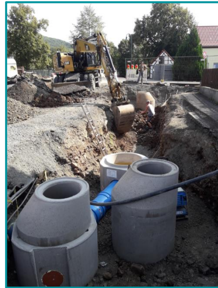
In der Ortslage Fischbach wurde ein neues Kanaltrennsystem verlegt.
