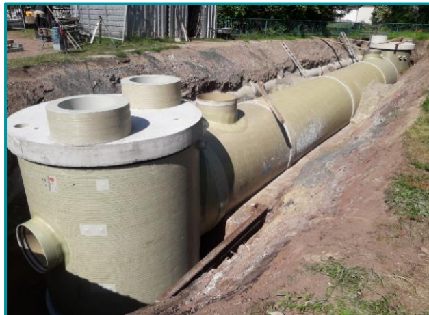
Unter der Parkanlage zwischen der „Wiesenstraße“ und dem „Kreuzweg“ ist ein 19 Meter langer Stauraumkanal entstanden.
