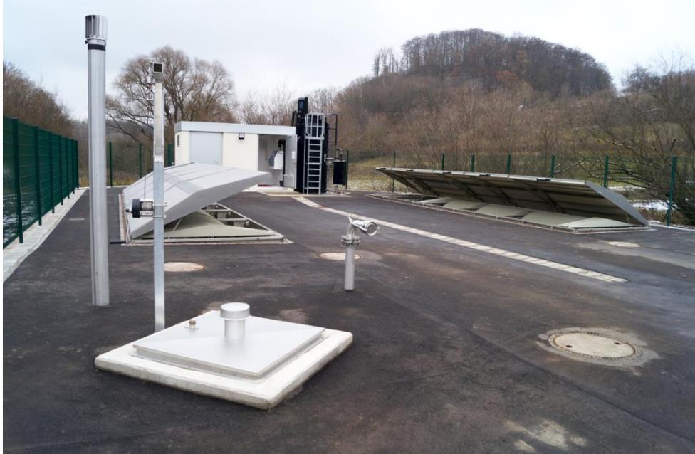
Die zentrale Kläranlage Klings ist seit Ende 2020 in Betrieb und kann pro Tag bis zu 110,59 Kubikmeter Schmutzwasser reinigen. Mit der Umsetzung der Kanalbaumaßnahmen in Klings wird der Anschlussgrad an die Abwasserbehandlungsanlage erhöht.
