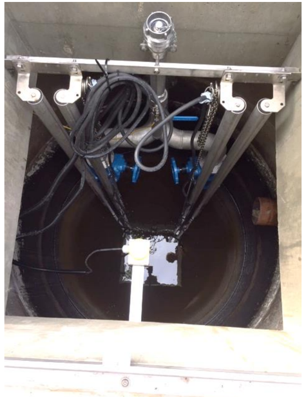
Das vorhandene Vorklärbecken der ehemaligen Wohngebietskläranlage wurde zur Pumpstation umgebaut.
