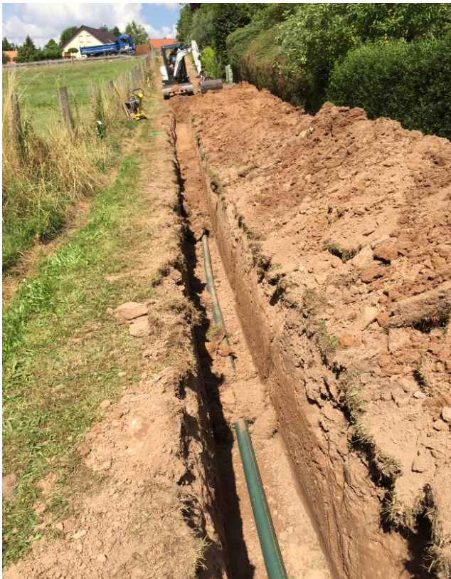
Verlegt wurden 170 Meter Abwasserdruckleitung bis zum Anschluss an den Kanalbestand in der Trift.
