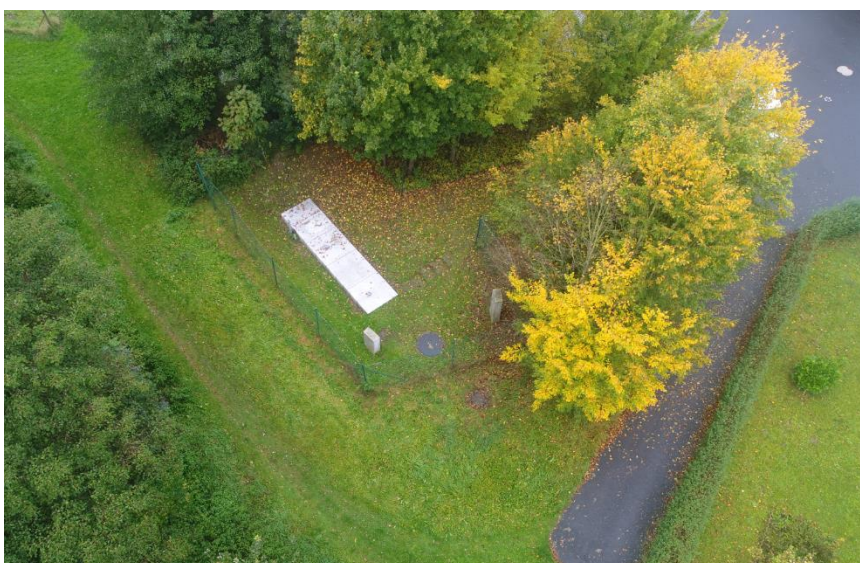
Die Wohngebietskläranlage in Gumpelstadt wurde außer Betrieb genommen.
