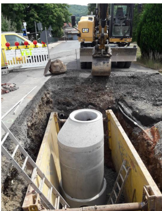
Arbeiten am Kanalnetz in Fischbach
