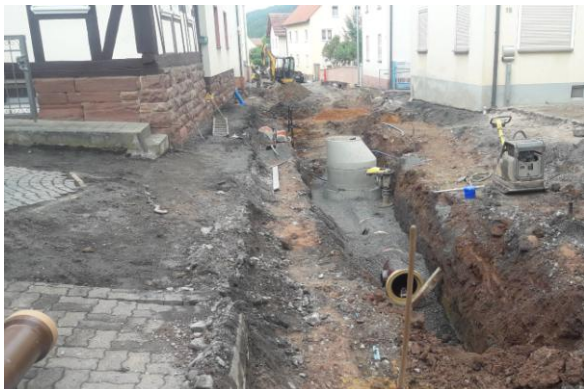
Kanal- und Trinkwasserleitungsbau in Bernbach
