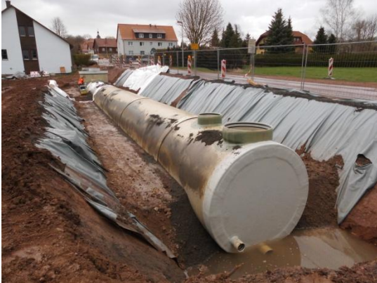
Stauraumkanal während der Bauphase (TO2)
